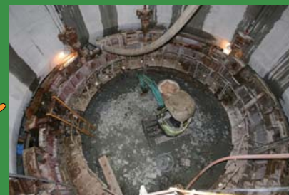
立坑の壁面に設置された型枠(鋼製)の様子
