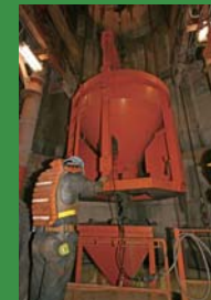
コンクリートを型枠へ流し込むためホッパーへ移し替えている様子
